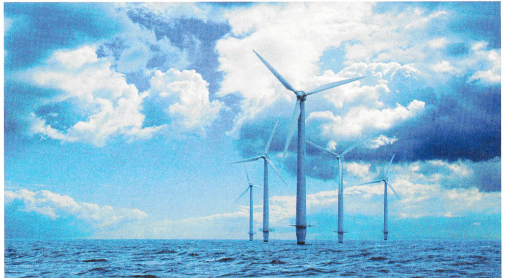
Windpark in der Ostsee (Foto NEG Micon).
