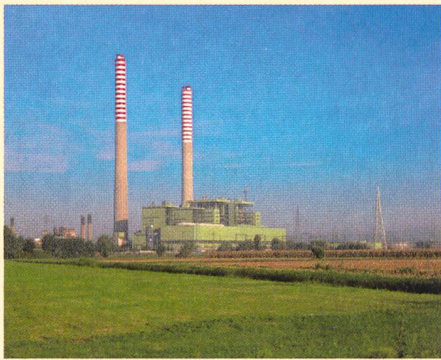
Teurer Umbau vom Ölkraftwerk zum Kohlekraftwerk (Zentrale Tavazzano, Bild Enel).
