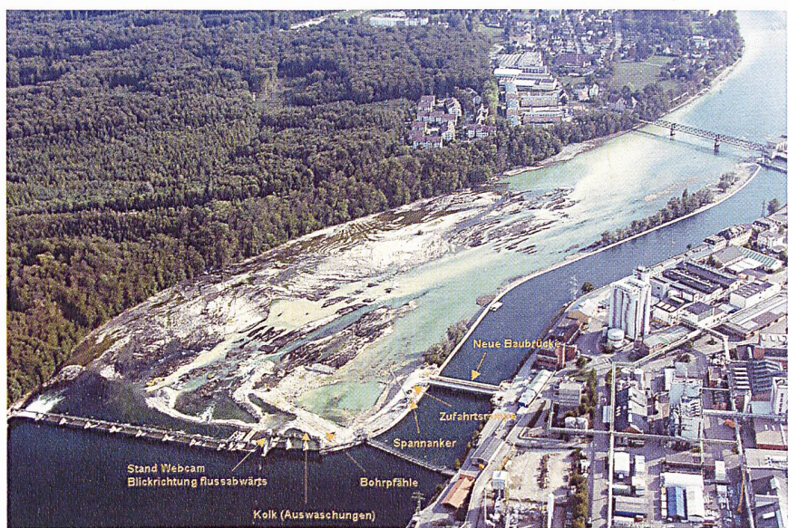
Neubauprojekt Wasserkraftwerk Rheinfelden: Luftaufnahme der Baustelle im Zuge der Bauarbeiten für die erste Etappe, das neue Stauwehr, das bis Mitte 2007 fertig gestellt sein soll. Rechts vom Wald die besondere Felsformation, das so genannte «Gwild», das weitgehend erhalten bleibt. Es wird so gestaltet, dass es die biologische Funktion des heutigen Gwilds weiter übernehmen kann (Foto: NaturEnergie AG).
