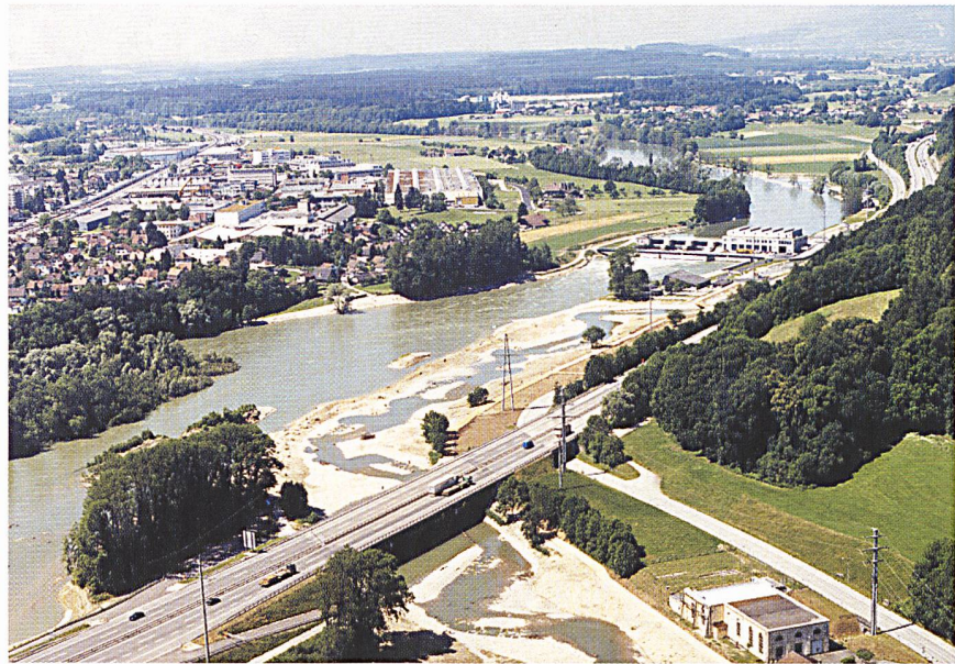
Landschaftsgestaltung beim Neubau des Kraftwerks Ruppoldingen an der Aare (Foto Buwal).
