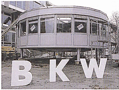
Das BKW-Info- und Meetingcenter «SOLEIL» vor der Installation auf dem Stadionsdach (Bild: bkw).
