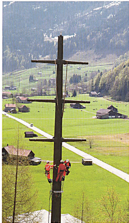
Die Mastspitze der Freileitung wird mit dem unteren Teil verbunden.
