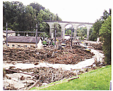
Hochwassersituation im Jahre 2002: Überflutetes SAK-Unterwerk in Goldach (Bild: sak).
