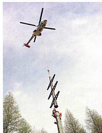
Aufstellen eines Strommastes mit Helikoptereinsatz (Bilder: sak).
