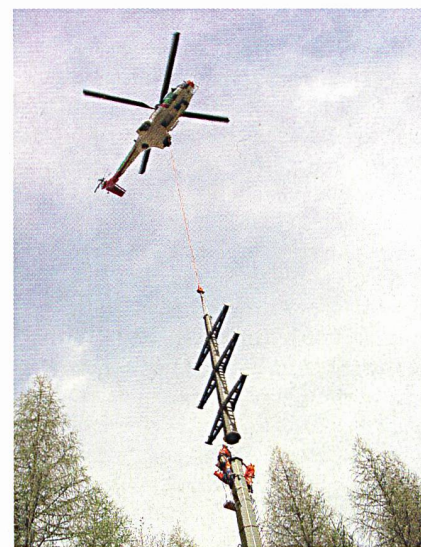
Aufstellen eines Strommastes mit Helikoptereinsatz (Bilder: sak).
