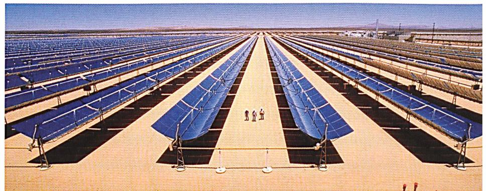
Schon heute produzieren die solarthermischen Kraftwerke in der kalifornischen Mojave-Wüste den günstigsten Solarstrom weltweit. Das Bild zeigt Parabolrinnenkollektoren, die Hochtemperaturwärme von 390 Grad Celsius erzeugen. Damit wird ein konventionelles Dampfkraftwerk betrieben (Bild: SEGS).
