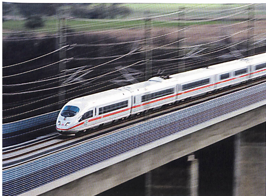
6000 Kilowattstunden von Hamburg nach Köln (Bild Deutsche Bahn).
