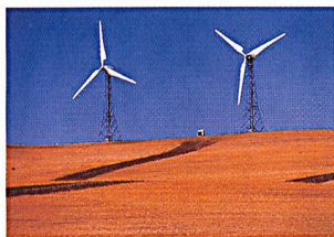
45 000 MW Potenzial für Windkraft in Indien (Bild Ecoenergy).
