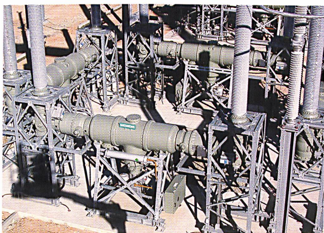
420-kV-Hochspannungs-Schaltanlage.
