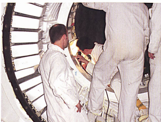
Inspektionsarbeiten am Rotor.
