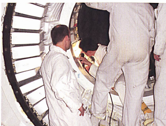
Inspektionsarbeiten am Rotor.
