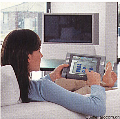
Vernetzte Haustechnik an der Future Building während der Messe Inteltec
