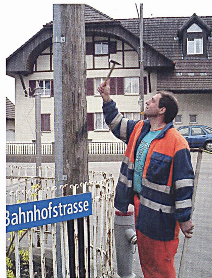
Kontrolle der Holzleitungsmasten.
