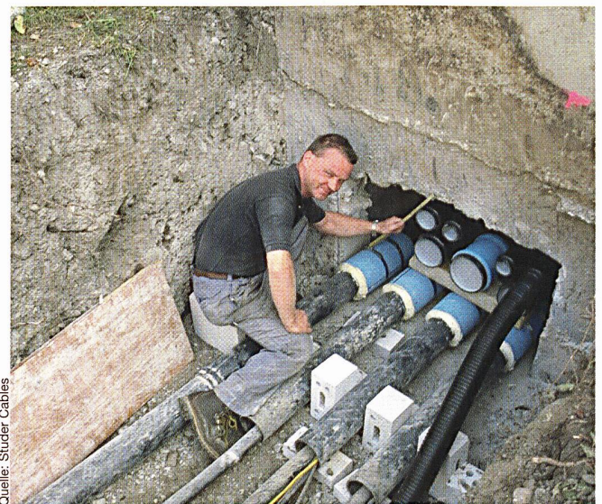
Bild 5 Sanierungen von Kabeleinführungen bringen oft Überraschungen und sind aufwändiger als Neubauten
