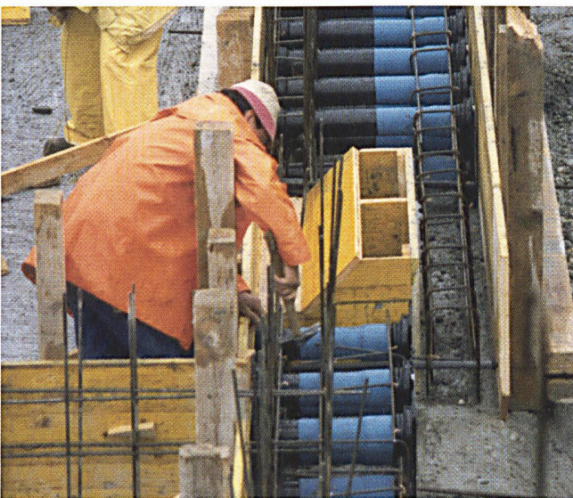
Bild 4 Bei Neubauten werden die Einführungen kostengünstig direkt in die Betonschalung montiert
