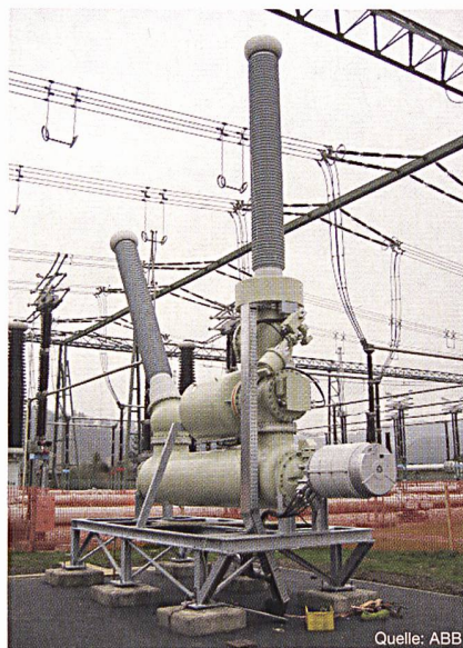
Bild 3 Neues 380-kV-Hybridschaltfeld
