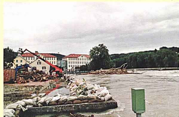
Viel Schwemmgut in der Reuss beim Kraftwerk Windisch.
