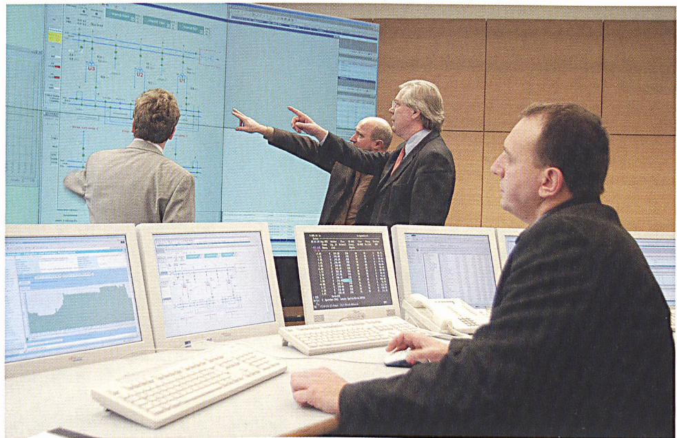
Die neue Technik fasst die unternehmenseigenen und die externen Anlagen zu einem einzigen virtuellen Kraftwerk zusammen.
