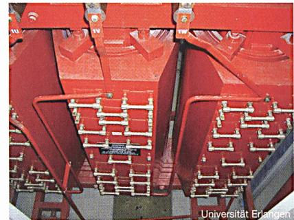
Bild 1 Oberspannungsseite des Hochstromtransformators
