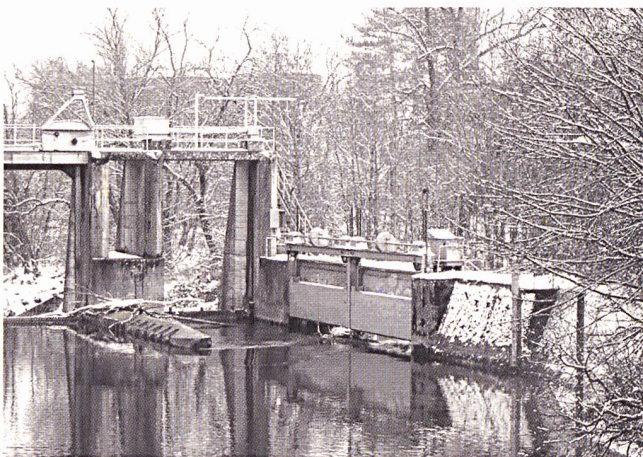
Bild 1 Beispiel für ein Kleinwasserkraftwerk. Kraftwerke dieser Grössenordnung können nach «Naturemade star»-Kriterien zertifiziert werden.
