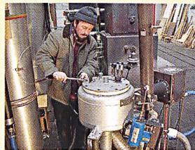
Forschung und Entwicklung im Bereich Energie aus Biomasse (Bilder: Langenbruck).
