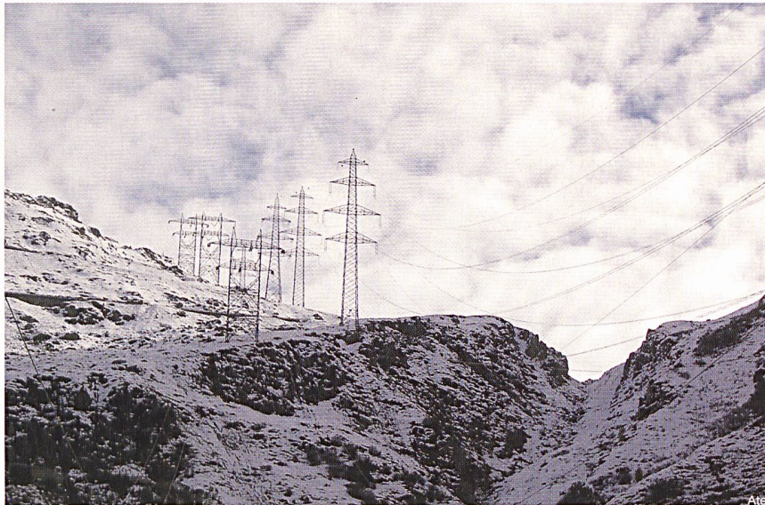
Bild 3 380-kV-Leitung über den Nufenenpass
