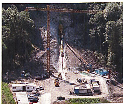
Baustelle in Oberrickenbach (Bild: Murer AG).
