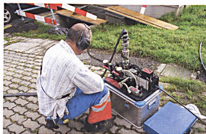
Ein Mitarbeiter der EKT AG überwacht das Einblasen der Glasfaserkabel (Bild: ekt).
