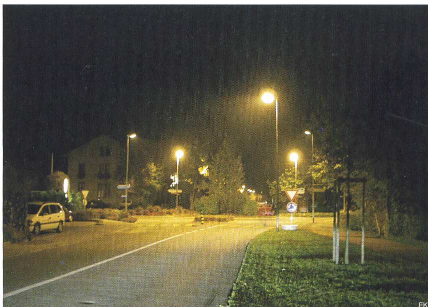
Bild 3 Beleuchtung eines Verkehrskreuzes mit Fussgängerstreifen
