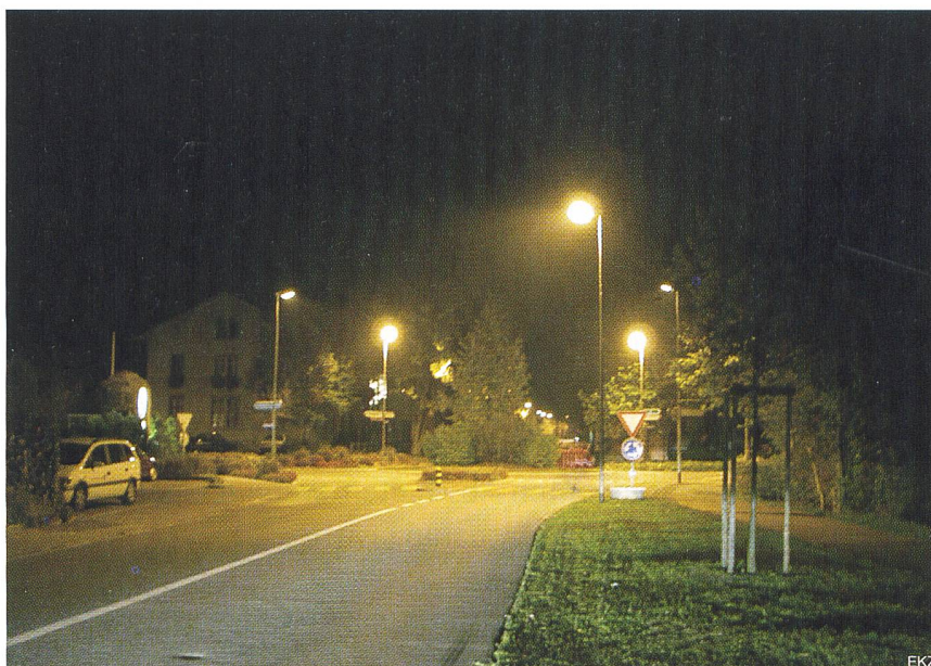
Bild 3 Beleuchtung eines Verkehrskreuzes mit Fussgängerstreifen
