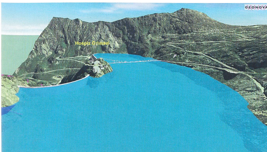
Grimsel Nollen mit neuer Hängebrücke nach Staumauererhöhung.
