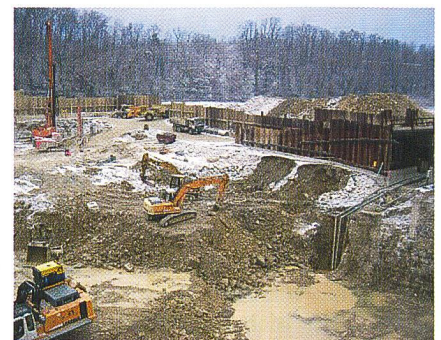
Arbeiten mitten im Rhein. Dank niedriger Wasserführung ist es möglich, mit schweren Baumaschinen ohne Probleme mitten im Rhein zu arbeiten.
