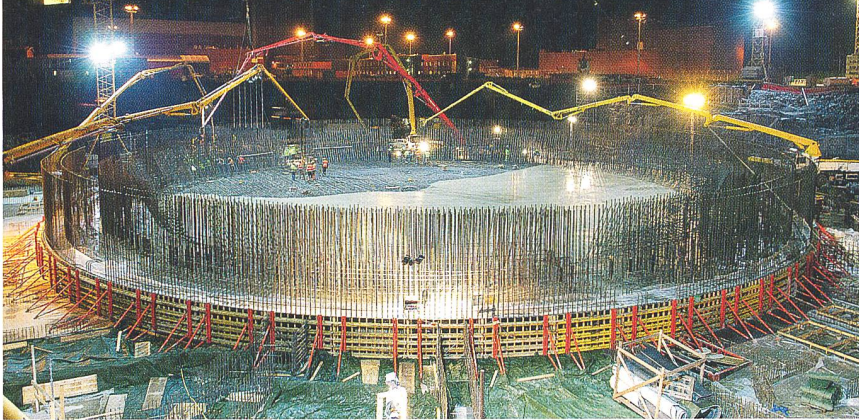
Baustelle des 1600-Megawatt-EPR-Kernkraftwerks Olkiluoto-3 (Bild Areva)
