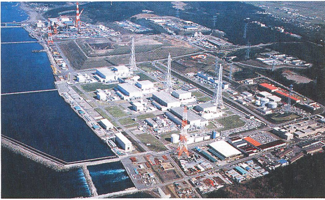
Druckwasserreaktoren Kashiwazaki-6 und -7 vom Typ ABWR (Advanced Boiling Water Reactor, hinten) in Japan. Sie wurden innerhalb vier Jahren gebaut und sind kleiner als die bisherigen Anlagen.
