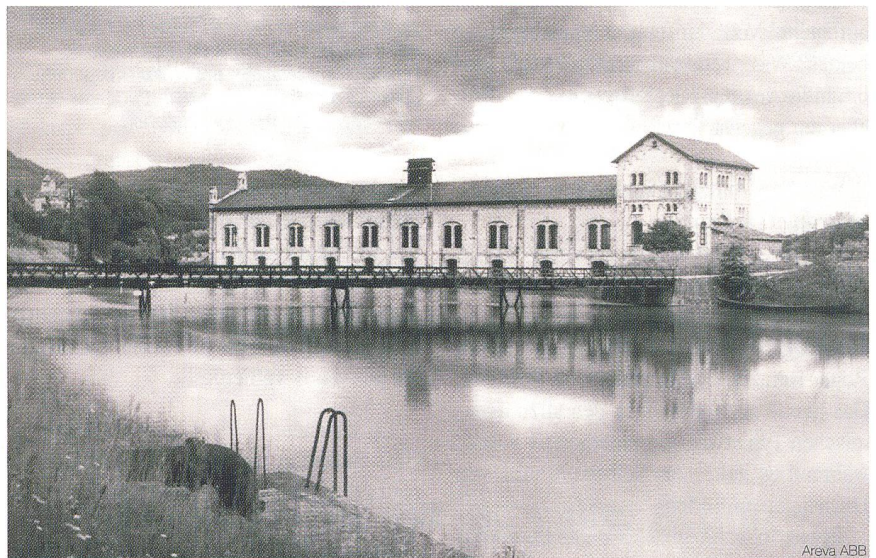
Baukunst aus den Pioniertagen des Kraftwerkbaus: Das Kraftwerk Ruppoldingen oberhalb von Aarburg im Kanton Solothurn wurde 1896 gebaut und verfügte über eine Leistung von 2500 PS. 1925 wurde es erstmals umgebaut und mit neuen Maschinen von gesamt 7000 PS ausgerüstet. Im Jahr 2000 wurde das alte Gebäude durch einen Neubau ersetzt. Das Kraftwerk produziert heute mit einer installierten Leistung von 23 MW (rund 31 000 PS) durchschnittlich 115 Mio. kWh pro Jahr.
