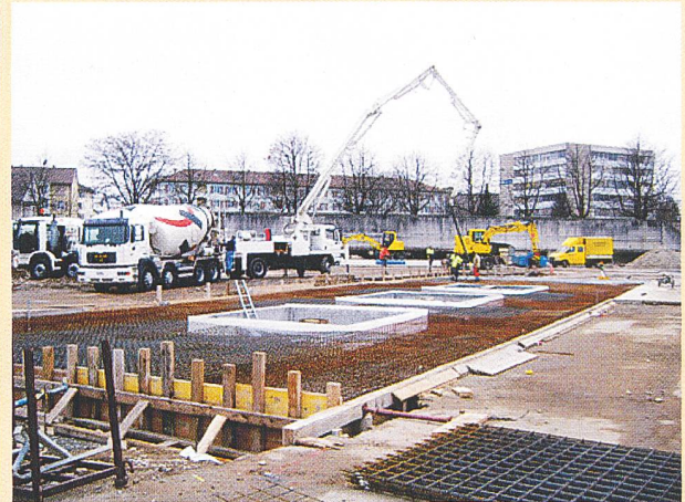
Bohrplatzvorbereitungen in Kleinhüningen/Basel (Bild Geothermal Explorers).
