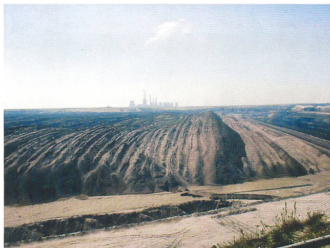
Tagebaukippe mit bestehendem Braunkohlekraftwerk Boxberg (Bild PIK).
