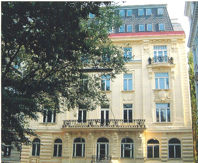
Der Verband der Elektrizitätsunternehmen Österreichs (VEÖ) erklärt dringenden Investitionsbedarf für die österreichische Elektrizitätswirtschaft (im Bild VEÖ-Sitz in Wien).
