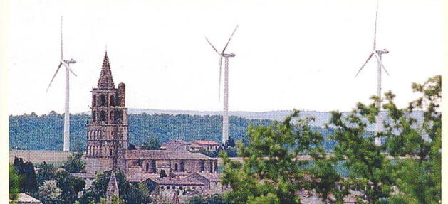
Höher als die Kirche von Avignonet – die Montage wagt den Beweis (Foto: Vent de Colère; Fayolle)
