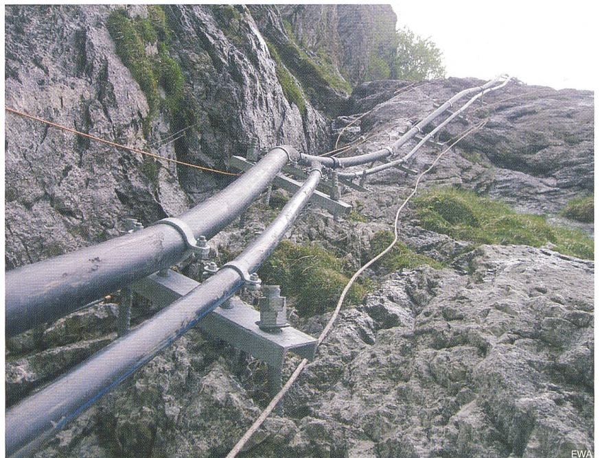
Bild 3 Verlegte Rohrleitungen in der Felswand vor der Meglisalp
