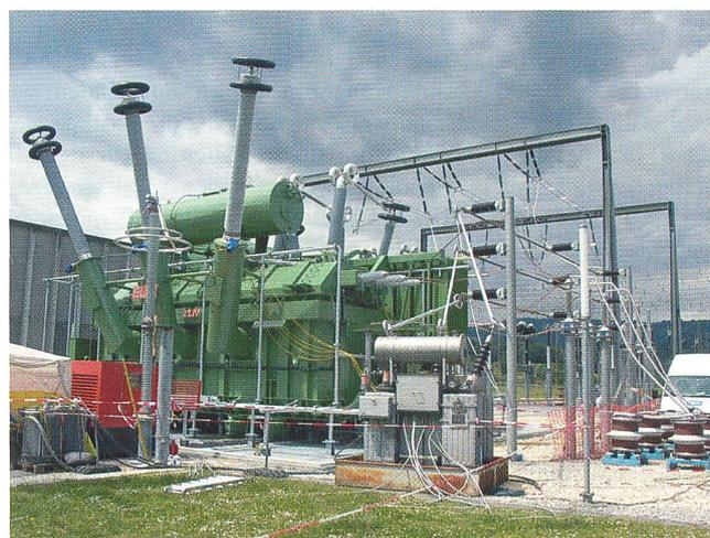
Bild 1 Netzkupplungstransformator mit Längs- und Querregelung in Bassecourt, hier bei der Hochspannungsprüfung nach der Montage
