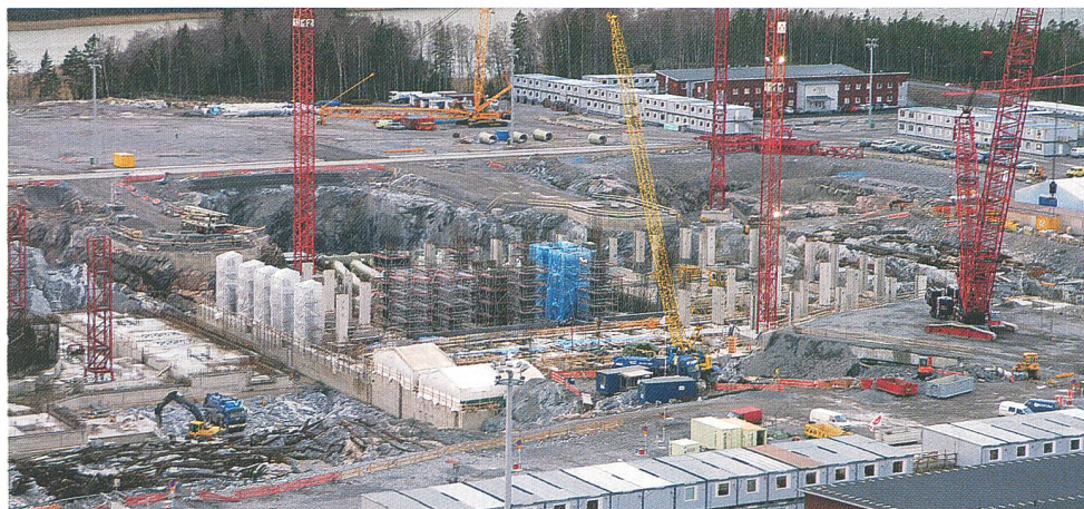
Das Projekt Olkiluoto 3 ist zurzeit rund neun Monate in Verzug. Die Anlage soll dennoch Ende 2009 in Betrieb gehen (im Bild die Baustelle/Foto TVO).
