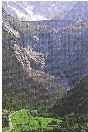
Albigna-Staumauer im Bergell (Bild: ewz).
