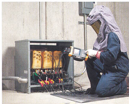
Netz- und Stromversorgungsanalysator von Fluke im Einsatz
