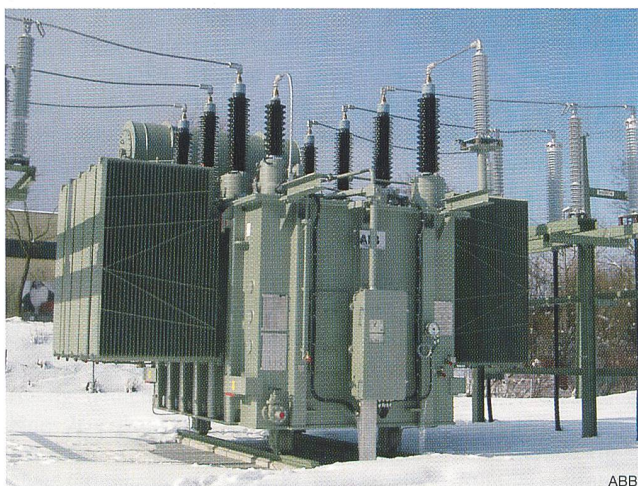
Bild 5 Querregeltransformator 100 MVA, 110 KV/110 KV
