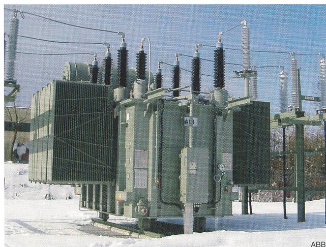
Bild 5 Querregeltransformator 100 MVA, 110 kV/110 kV
