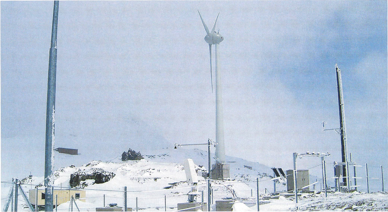
Dass eine Windkraftanlage nicht nur Ökostrom produziert, sondern auch für die internationale Forschung zur Vereisungsproblematik genutzt wird, zeigt die in 2332 Metern Höhe auf dem Gütsch oberhalb Andermatt installierte Anlage (Foto: EW Ursern).
