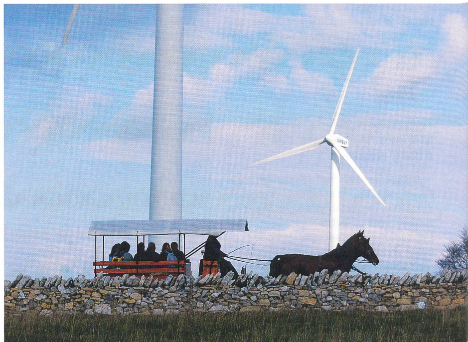
Schrittweise konnte die Juvent SA im Jura ihre Windkraftkapazitäten seit 1996 ausbauen. Heute stehen acht Windturbinen im Einsatz, die 2005 über 7 Mio. kWh Strom erzeugt haben (Foto: Juvent SA).
