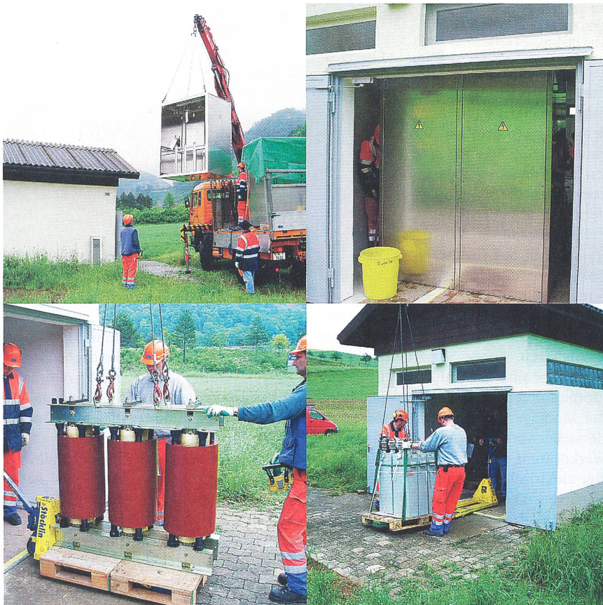
Montage der Kompensationsanlage.
