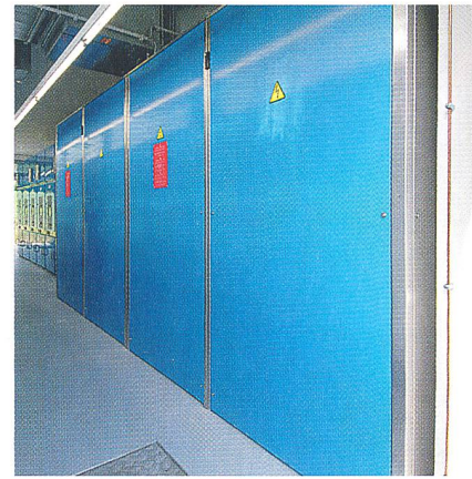
Die zwei Doppelzellen der Rectiphase-Kompensationsanlage.
