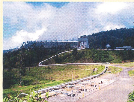
In Indonesien sind in den letzten Jahren zahlreiche geothermische Kraftwerke entstanden (im Bild 81-MW-Anlage Darajat).
