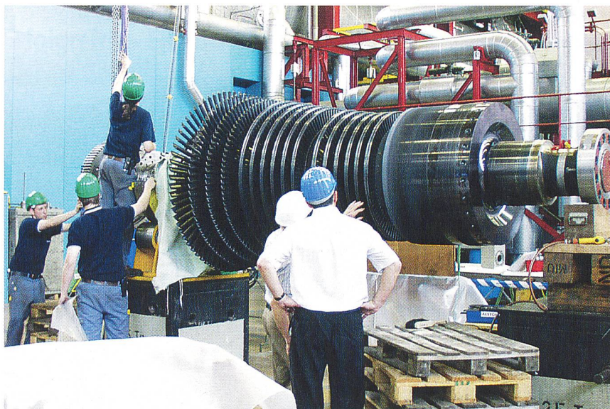
Eine der beiden Hochdruckturbinen von Block 1 des KKB wird revidiert (Bild: nok).
