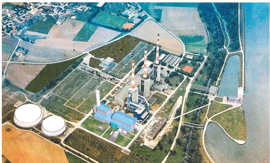
Öl- und Gas-Kombikraftwerk (Bild Siemens).
