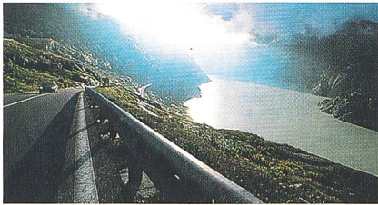
Grimselpassstrasse (Bild: kwo).
