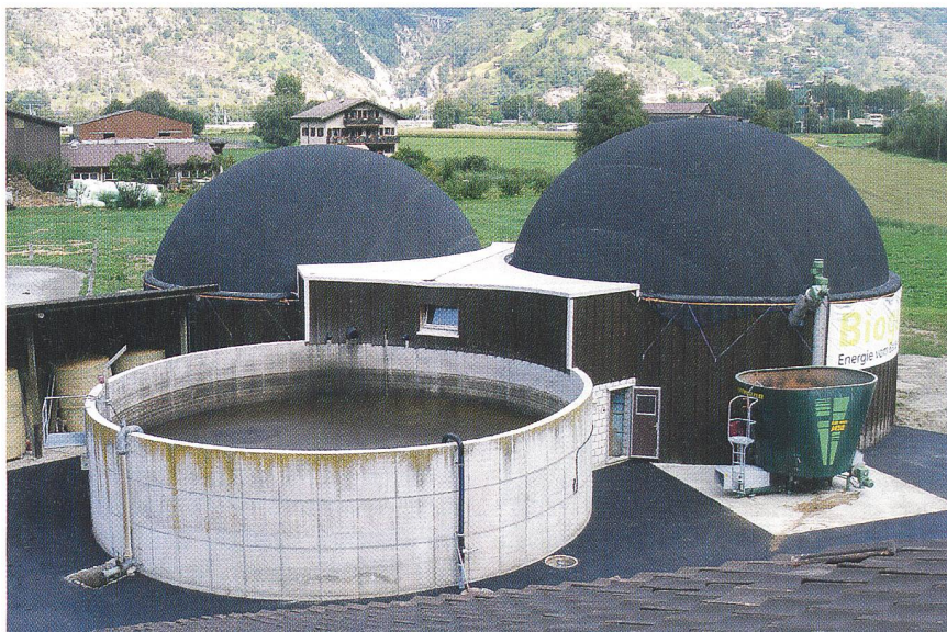
Aus Gülle und Mist wird Ökostrom und Wärme: Neue Biogasanlage in Visp (Bild: biomasseenergie.ch).
