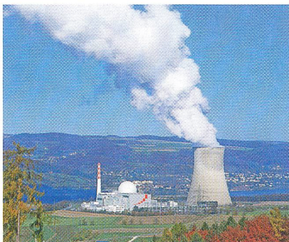
Die Industrietagung nuclea des Nuklearforums Schweiz fand im Kernkraftwerk Leibstadt statt – Le congrès industrie nuclea du Forum nucléaire suisse s'est tenu dans la centrale nucléaire de Leibstadt
