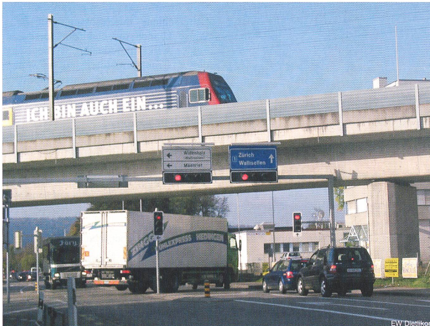
Bild 6 Die mit der SBB-Erde verbundene Lichtsignalanlage arbeitet seit 1997 störungsfrei
