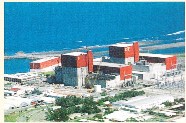
Bereits in Betrieb: zwei Kernkraftwerke (2x680 MW) in Laguna Verde.
