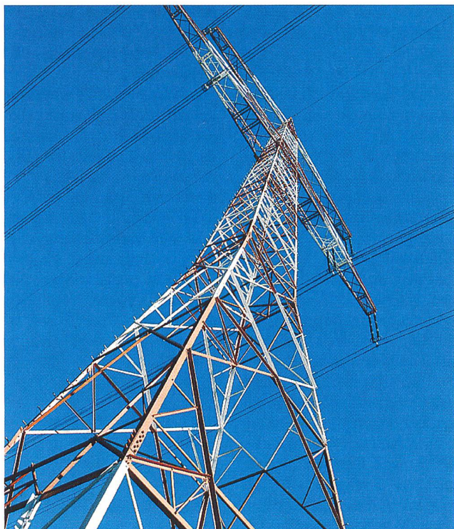
Keinerlei Hinweise für technische Fehlfunktionen von Leitungen (Bilder E.ON).
