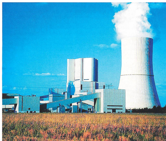
Für den Standort Boxberg (Ostdeutschland) liegen verschiedene neue Projekte vor (Bild Vattenfall).
