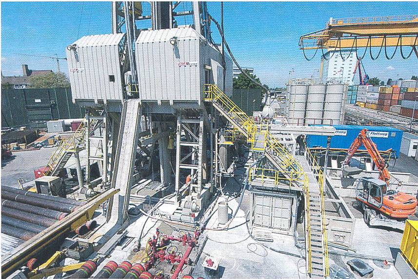
Bohrstelle in Kleinhüningen Basel (Bild: geothermie).
