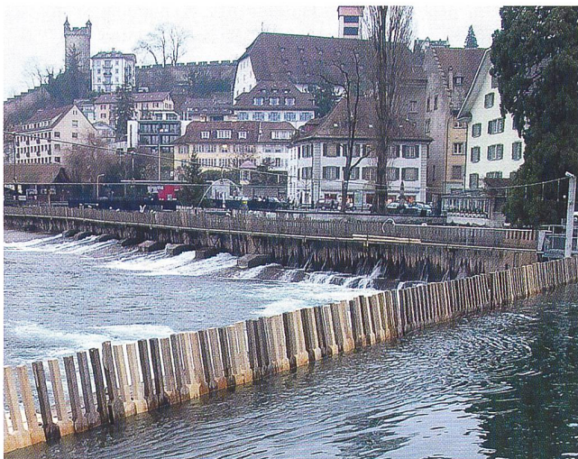
Luzern ersetzte um 1860 die Reuss-Schwelle des 16. Jahrhunderts, welche das Wasser zu den Mühlen leitete, durch ein Nadelwehr. Dieses stabilisiert den Wasserstand des Vierwaldstättersees und regelt den Abfluss der Reuss. Zur Regulierung werden die Nadeln noch heute von Hand herausgezogen bzw. hinuntergestossen. Einem Hochwasser wie 1999 kann die einzigartige Anlage jedoch nicht mehr standhalten (Bild: swissworld).
