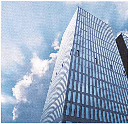
Die Arbeitsplätze in den 88 m und 72,5 m hohen Türmen des Sunrise Towers werden mit einer Komfortlüftung vor Überhitzung und Unterkühlung geschützt. Das gesamte Gebäude entspricht den Anforderungen von Minergie. (Bild: Archiv Oel)
