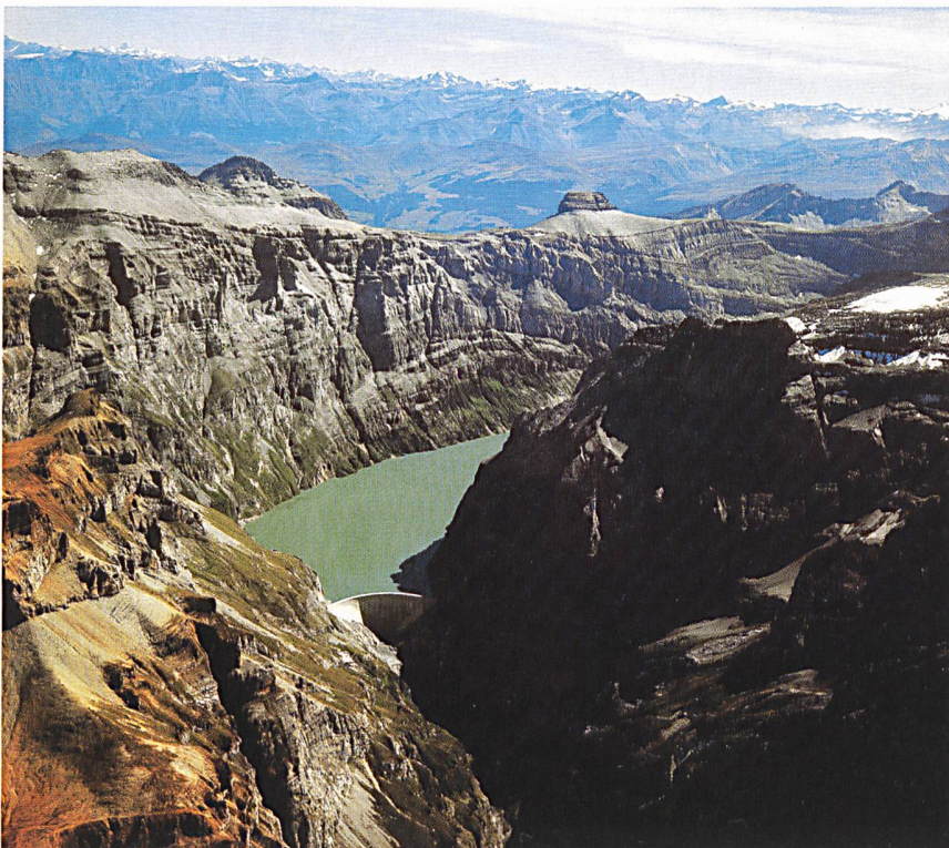
Bestehende Anlage Limmernsee der Kraftwerke Linth-Limmern (Bilder Axpo).
