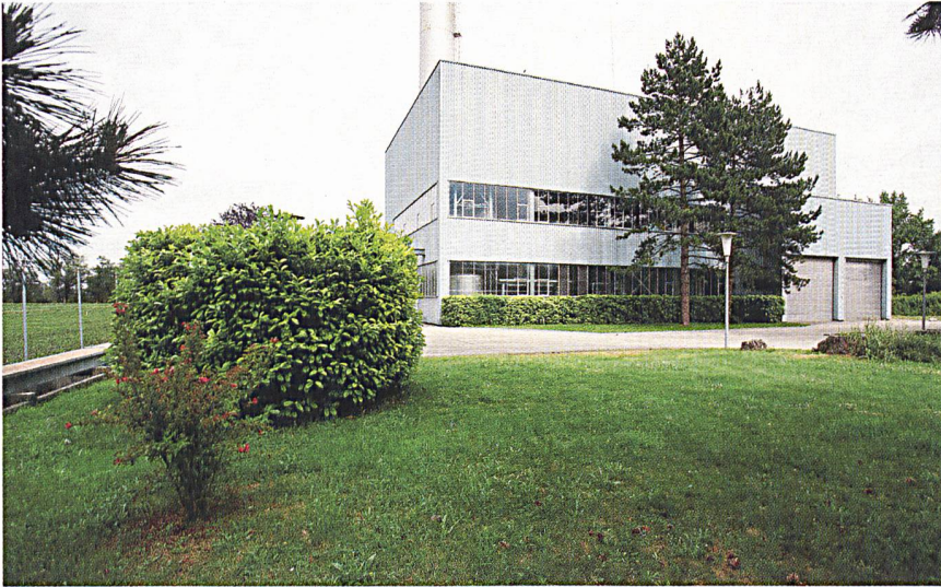
Centrale thermique actuelle de Cornaux.
