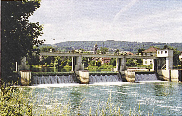
Totales Schweizer Wasserkraft-Ausbaupotenzial: maximal 5 TWh Jahresproduktion (im Bild Kraftwerk Dietikon/Bild VSE/m).
