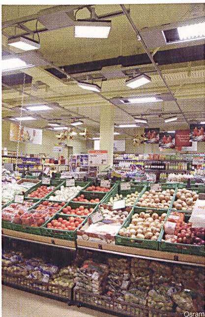
Esswaren mit LEDs beleuchten: Beim Gemüse oder Fleisch werden die weissen LEDs mit roten und grünen LEDs gemischt, um den Farbeindruck zu verbessern.
