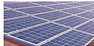
Photovoltaik-Indach-Montagesystem (Bild: Schweizer).
