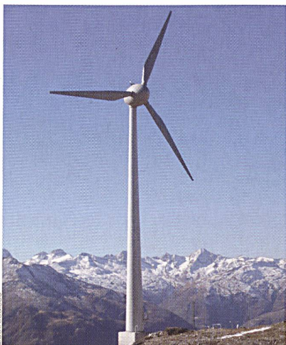
Die schwankende Windenergie fordert die Netzbetreiber heraus
