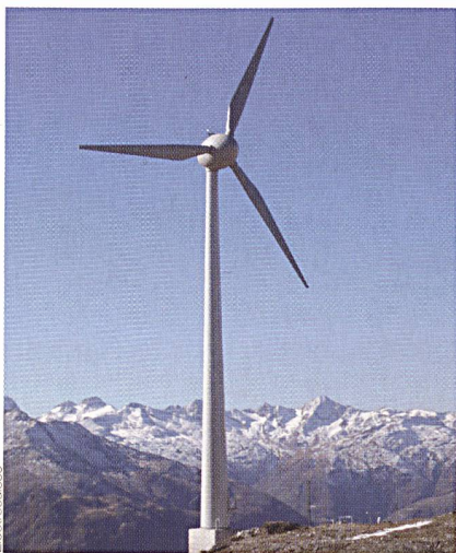
Die schwankende Windenergie fordert die Netzbetreiber heraus
